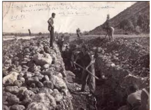
(Mario Piroli mentre assiste ai lavori di scavo)
